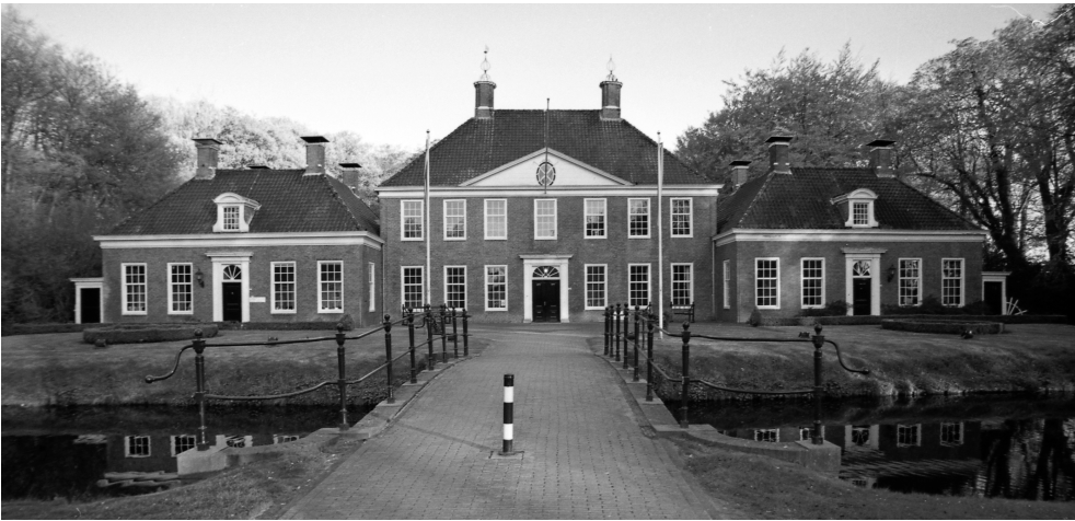
Laarwoud, Van Heiden Reinesteins Drentse huis. Foto van Peter van der Wielen (Collectie Nederlandse Kastelenstichting)
